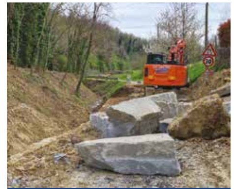
Via del Casserone. Lavori in corso
