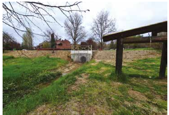
Rio Marzano. Vista del tombamento rialzato e con il nuovo parapetto posato
