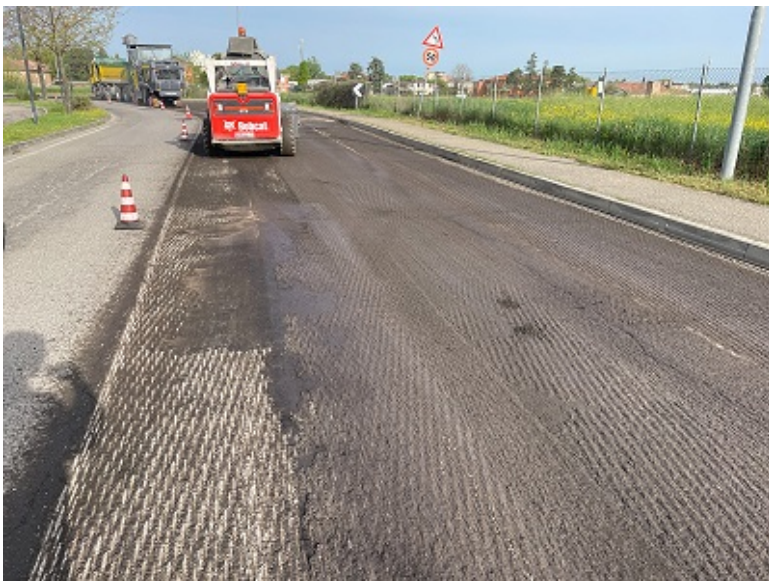
Lavori di asfaltatura in Via Nardi
