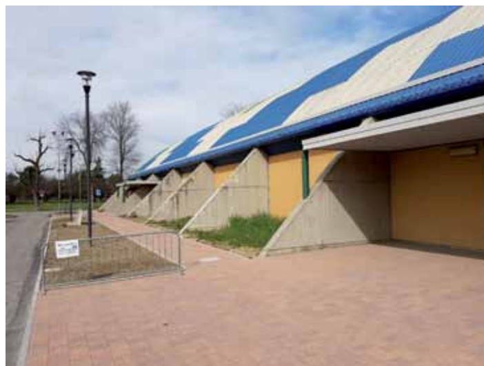
Fronte palazzetto DOPO i lavori
