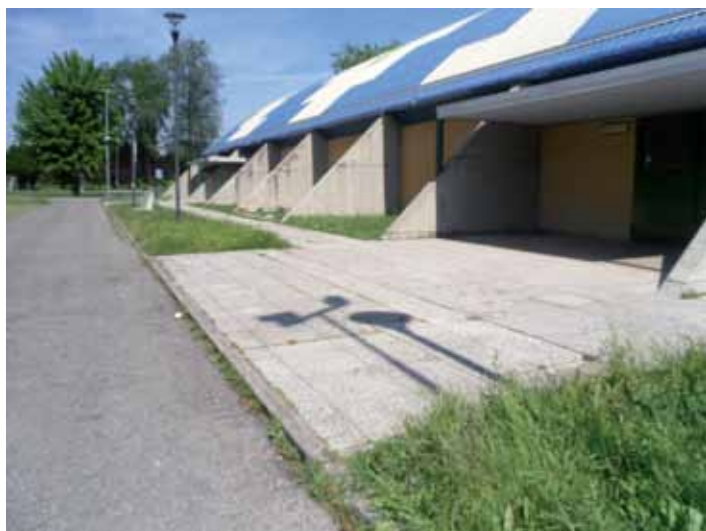
Fronte palazzetto PRIMA dei lavori
