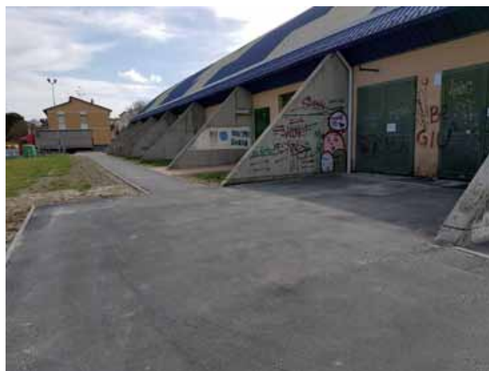
Retro palazzetto DOPO i lavori
