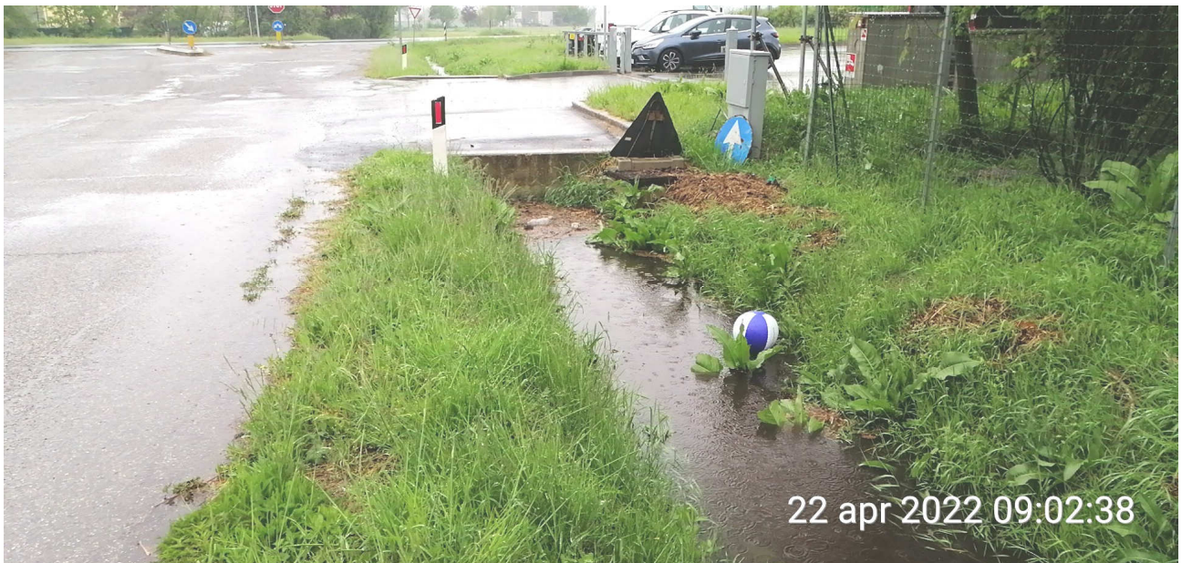
Foto 5 - Fosso ovest Via Ca' Fornacetta in direzione sud, nei pressi ingresso G2 servizi srl
