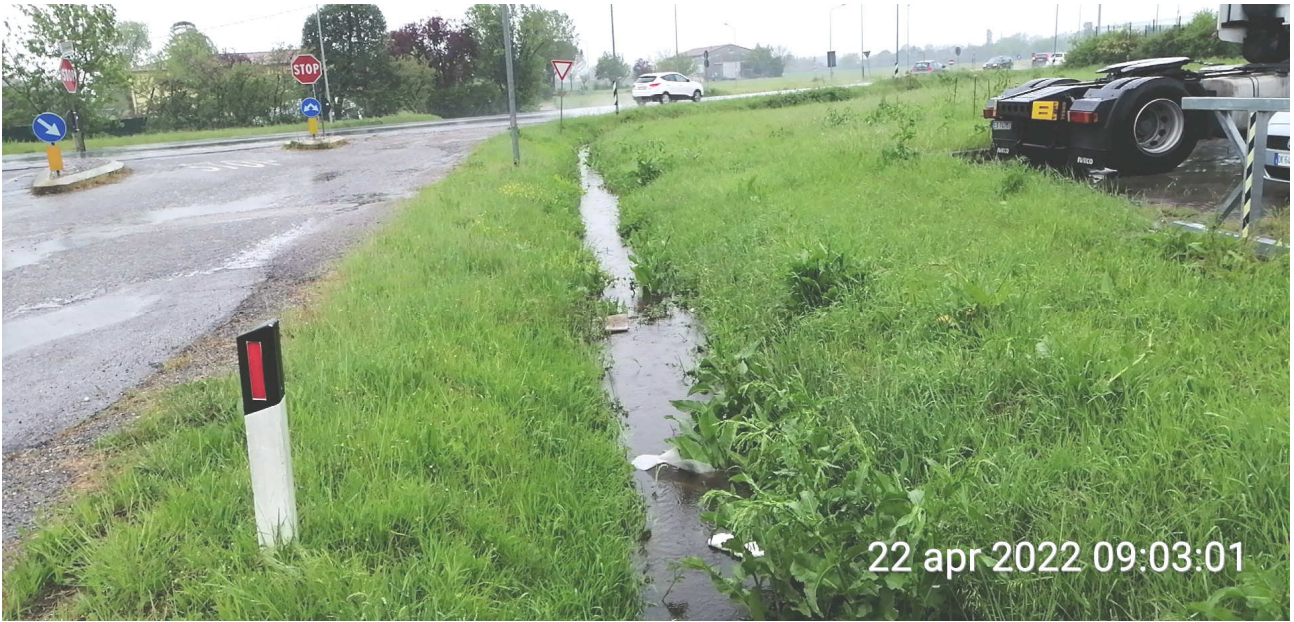
Foto 6 - Fosso ovest Via Ca' Fornacetta in direzione sud, all'arrivo su Via Stradelli Guelfi
