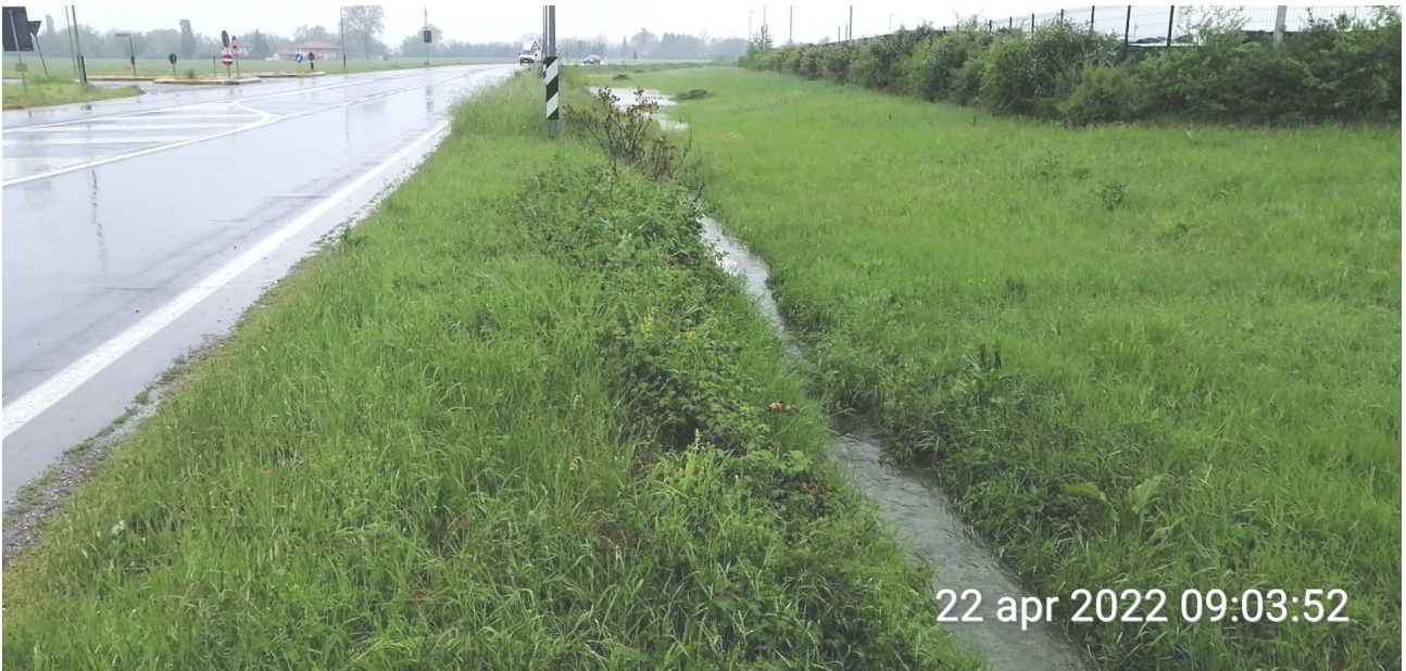
Foto 7 – Fosso nord Via Stradelli Guelfi
