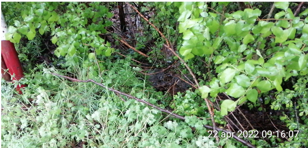
Foto 12 – Fosso est Via Ca' Fornacetta all'uscita del tombamento
