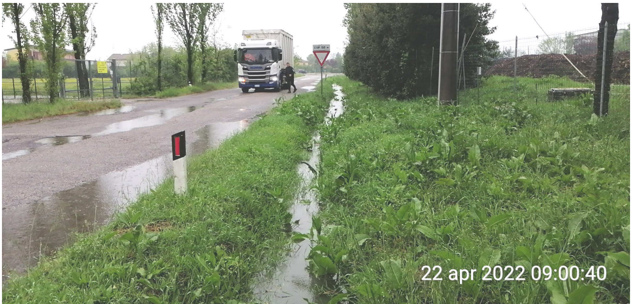
Foto 2 – Fosso ovest Via Ca' Fornacetta in direzione sud, scolo acque Hera spa
