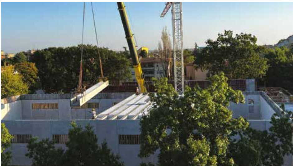
Blocco palestra - posa delle travi di copertura
